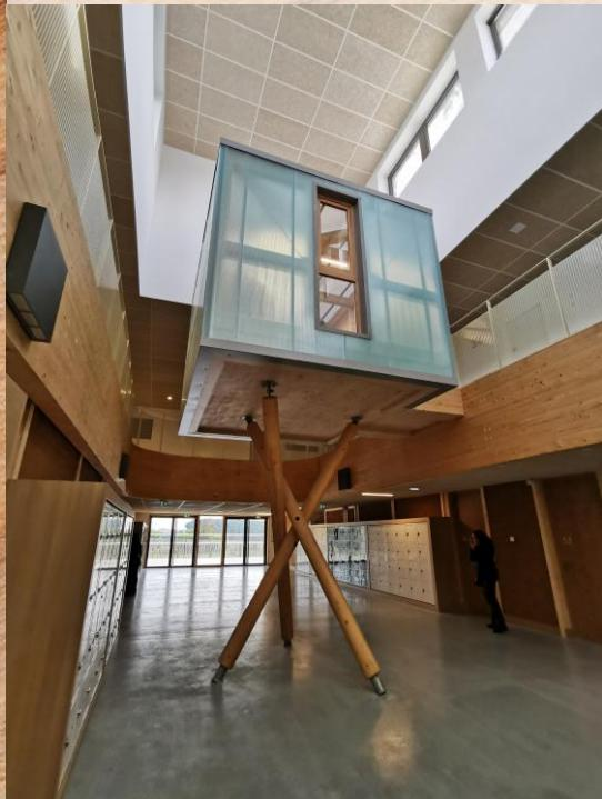
En plus d'être énergétiquement très performant, cet établissement utilise des matériaux locaux biosourcés et géosourcés pour son enveloppe réalisée par l'entreprise ALD Bois (+ de 1500 m<sup>3</sup> de bois en ossature et charpente, isolation paille et enduits terre crue issue du site).
